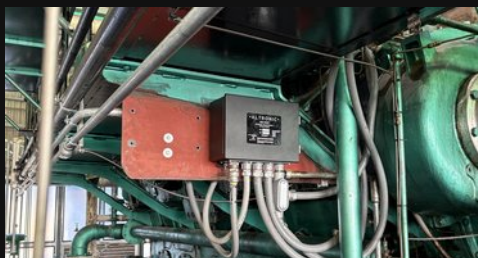
DCPM — INSTALACIÓN EN CAMPO
